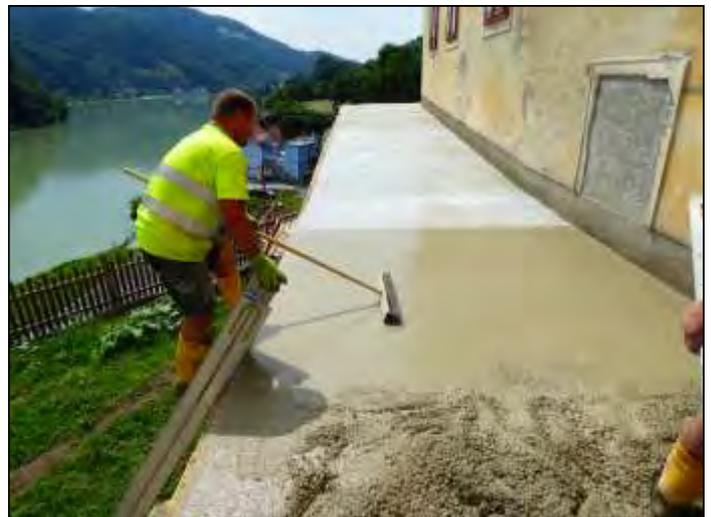
*Die Oberfläche des Betons wurde als „Besenstrich“ ausgeführt.*
